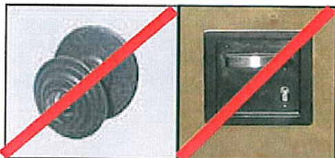
Bild 3 Türknäufel und eingelassener Türgriff sind für motorisch eingeschränkte Menschen schwer bedienbar und somit ungeeignet.
