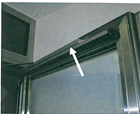
Bild 6 Infrarotvorhangschiene zur Anwesenheitskontrolle (weißer Pfeil) Quelle: Firma Bircher Reglomat AG, CH-Beringen
