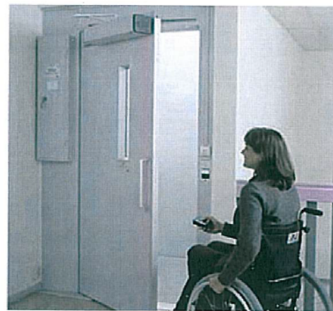
Bild 7 Low-Energy-Antriebe bieten guten Komfort für vergleichsweise kleines Geld. Quelle: Fachverband Türautomation (FTA), Hagen
