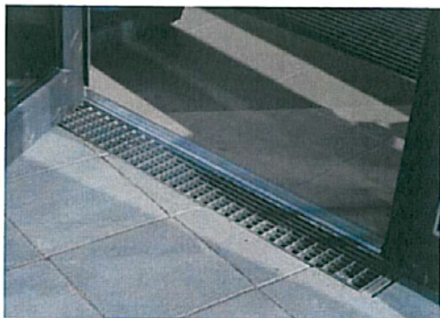
Bild 4 Schwellenfreier Zugang mit Wassersammelrinne und Gitterrost
